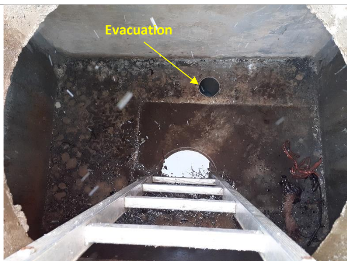
Le bac de pied sec, avec l'évacuation au sol et l'échelle d'accès
