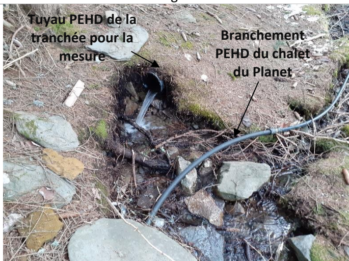
Détail du tuyau PEHD de la tranchée
