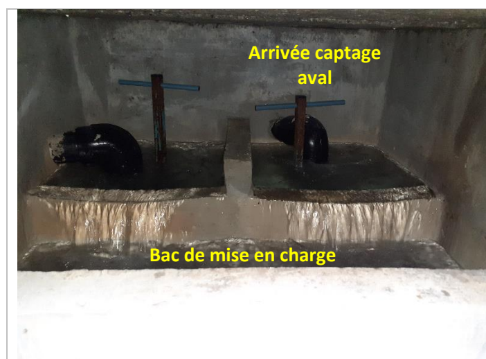
Vue d'ensemble des bacs de réception et de mise en charge (ou de départ)
