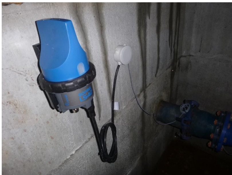
Exemple de poste local indépendant dans une chambre de vannes
