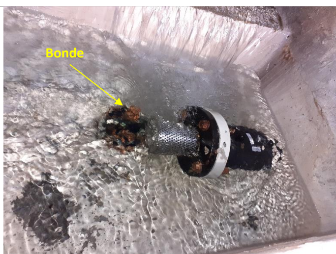
Le bac de mise en charge avec le départ crépiné et la bonde de fond
