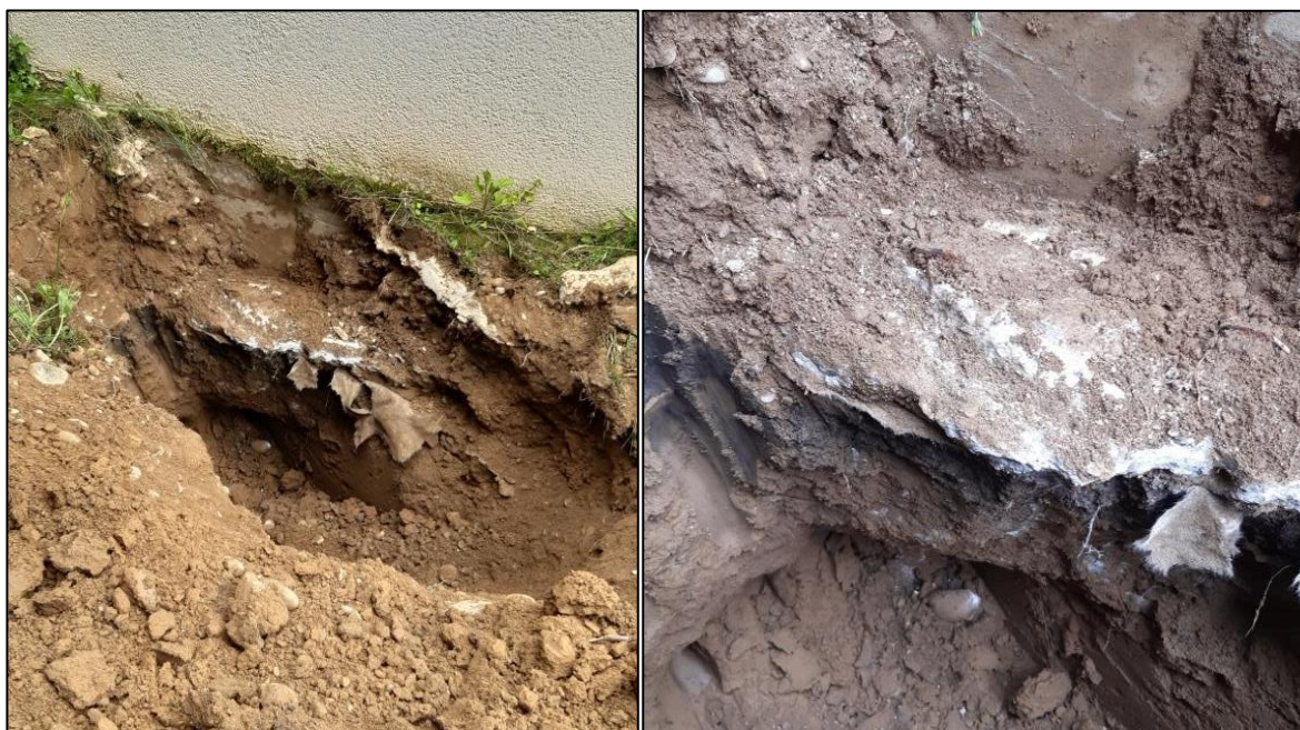
Figure 10 : Photographies du sondage de reconnaissance de fondation RF1 (ALIOS 02/07/2024).
