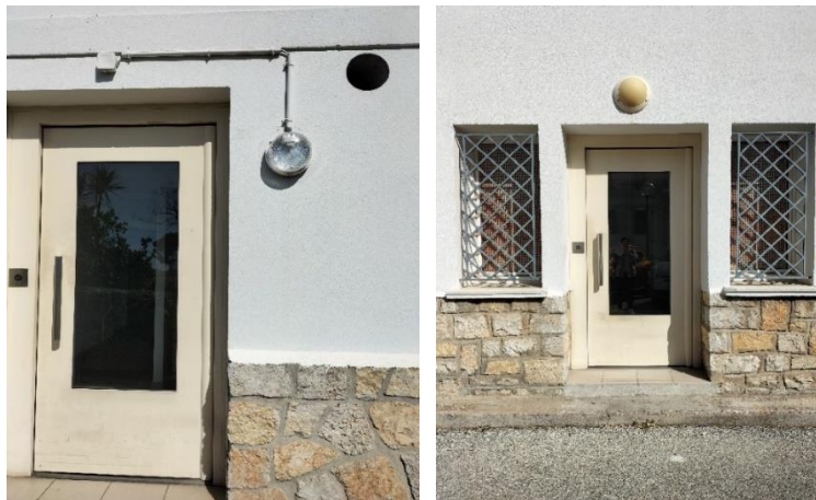
Figure 13 : Hublots et câblage électrique sur la façade.
