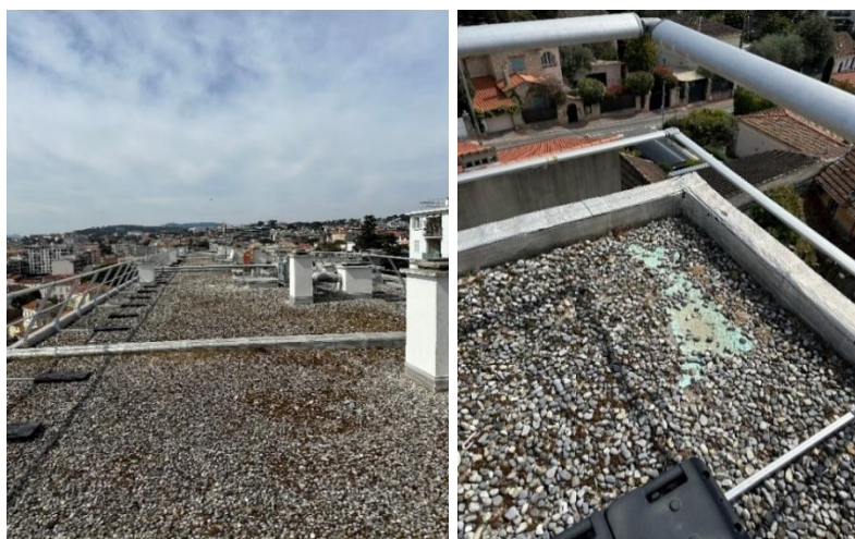
Figure 7 : Photographies de la toiture terrasse (à droite, l'isolant en polystyrène extrudé mis à nu)
