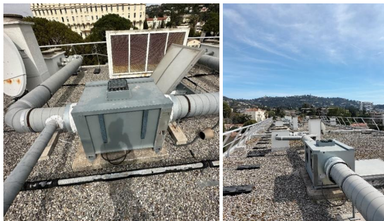
Figure 9 : Réseau VMC en toiture.
