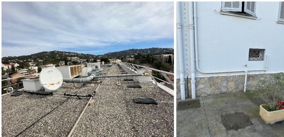
Figure 5 : Conduites AEP traversant la façade et les toitures.
