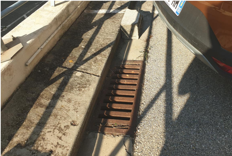
Figure 14 : Réseau existant (caniveau et grilles avaloirs) pour la gestion des eaux pluviales du parking haut – ICTP 2022
