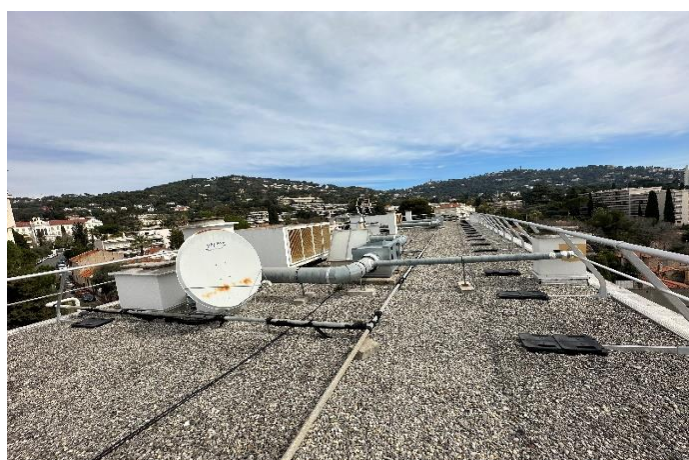
Figure 8 : Conduites AEP traversant la façade et les toitures.
