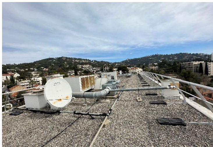
Figure 7 : Conduites AEP traversant les toitures.
