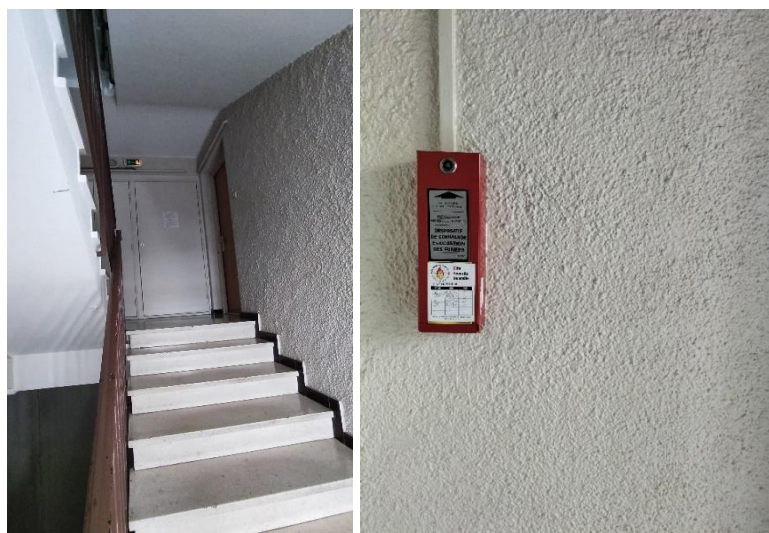
Figure 8 : Enduit gouttelette au niveau des cages d'escalier.
