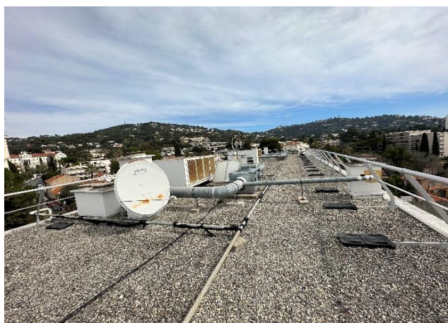
Figure 12 : Conduites d'AEP traversant la façade et les toitures.
