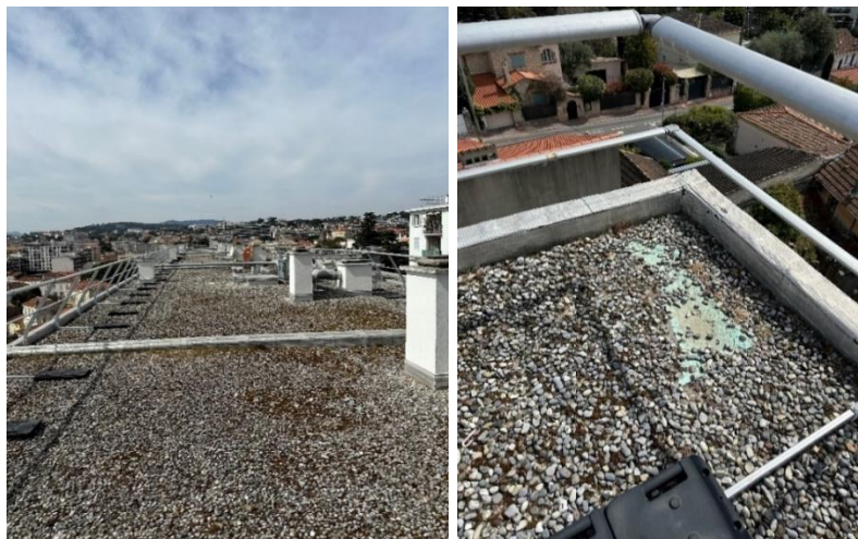
Figure 4 : Photographies de la toiture terrasse (à droite, l'isolant en polystyrène extrudé mis à nu)
