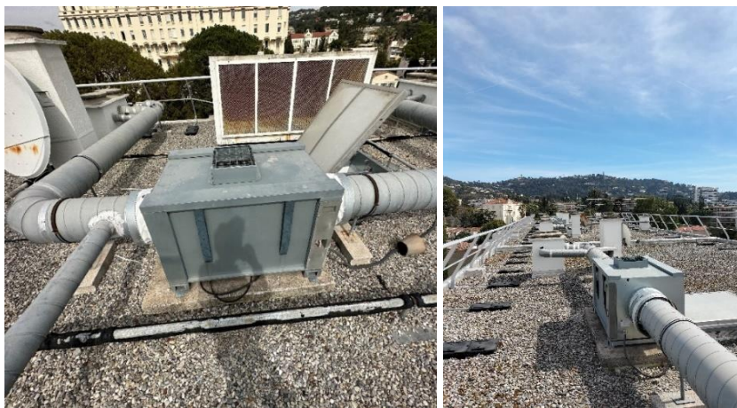
Figure 6 : Caissons d'extraction en toiture et grilles de ventilation en façade.
