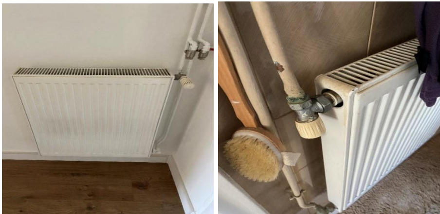
Figure 15 : Photographie des radiateurs et robinets thermostatiques existants.
