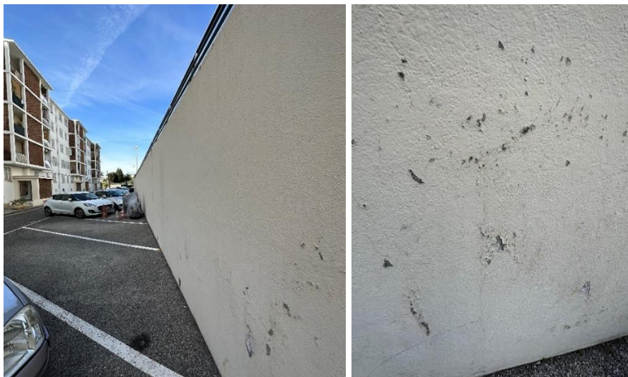
Figure 9 : Mur du parking intérieur (à droite, cloquage et écaillage des peintures).
