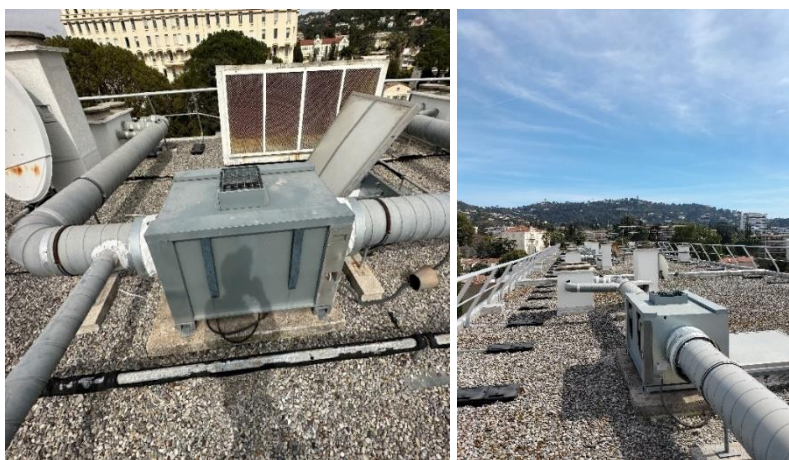
Figure 10 : Réseau VMC en toiture.
