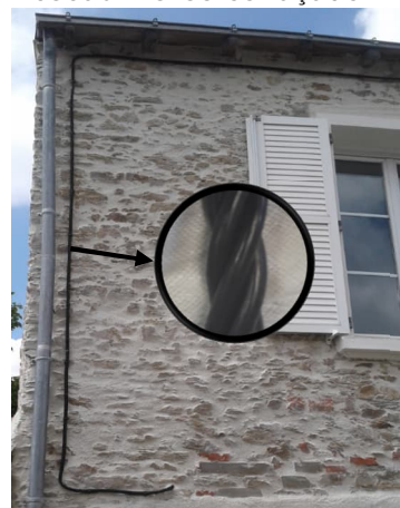
Réseau fils isolés façade BT
