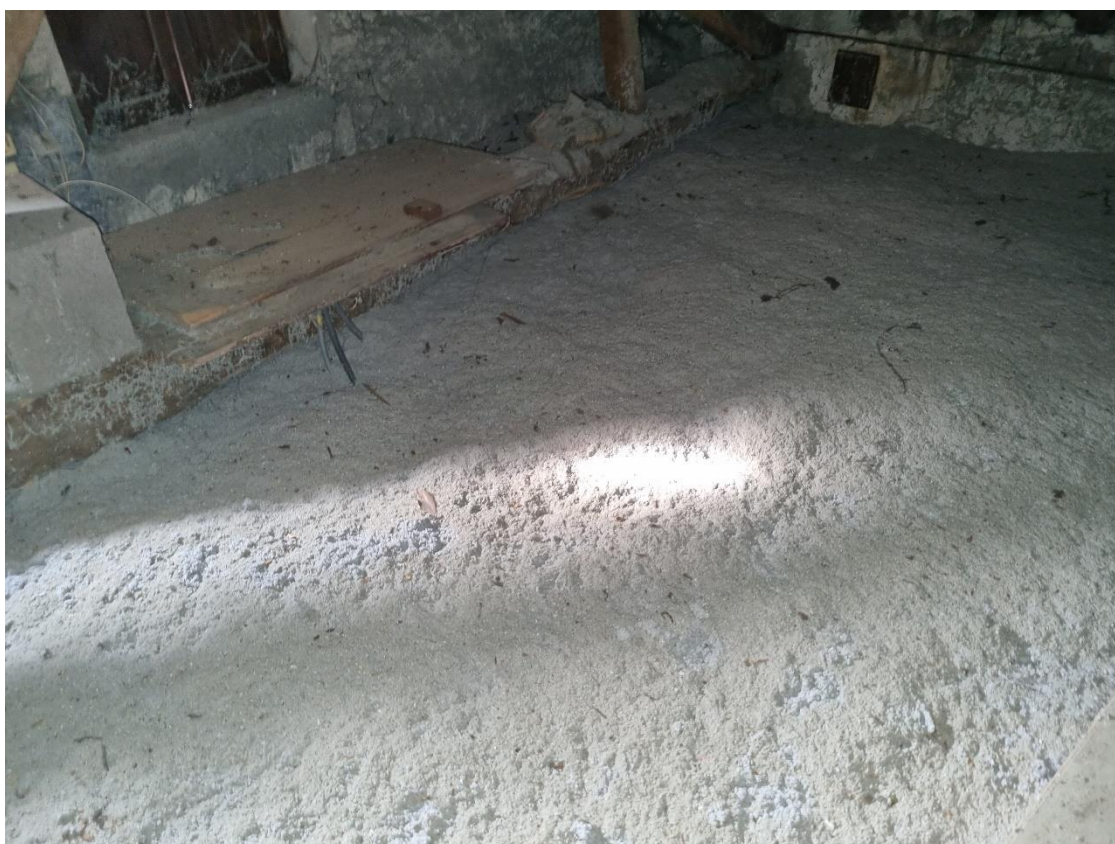
3. Ouate de cellulose en combles
