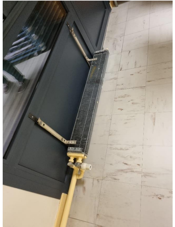
13. Radiateurs monotube bâtiment ancien avec et sans habillage
