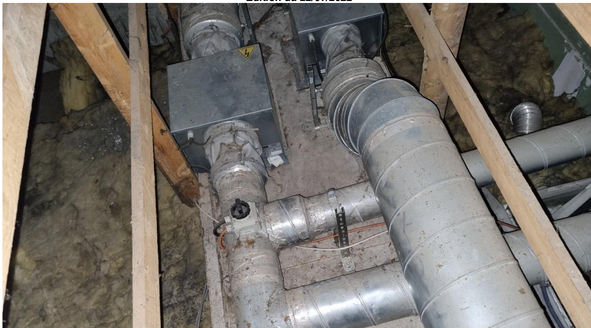
19. Caisson d'extraction en combles
