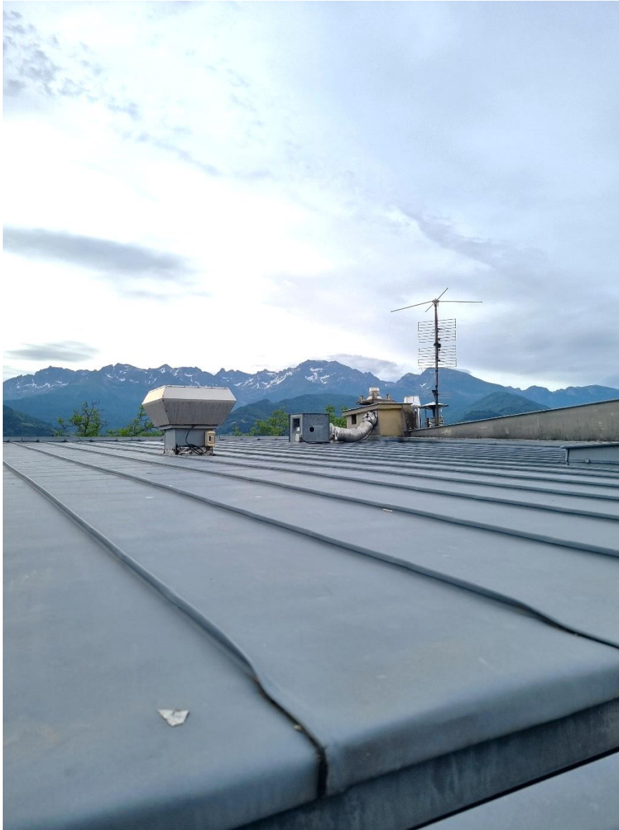
18. Tourelle d'extraction et caisson simple flux
