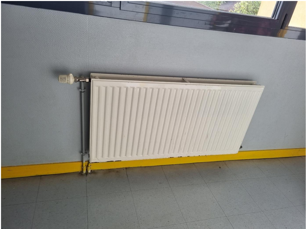
14. Radiateur bitube extension
