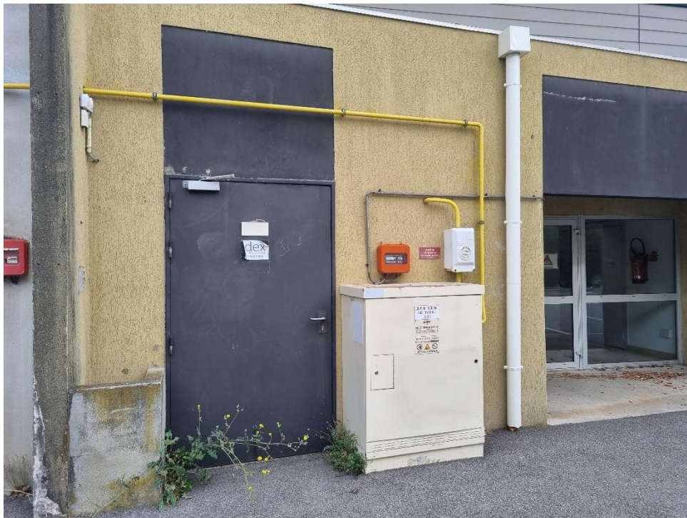
10. Coffret de coupure général gaz et coupure chaufferie
