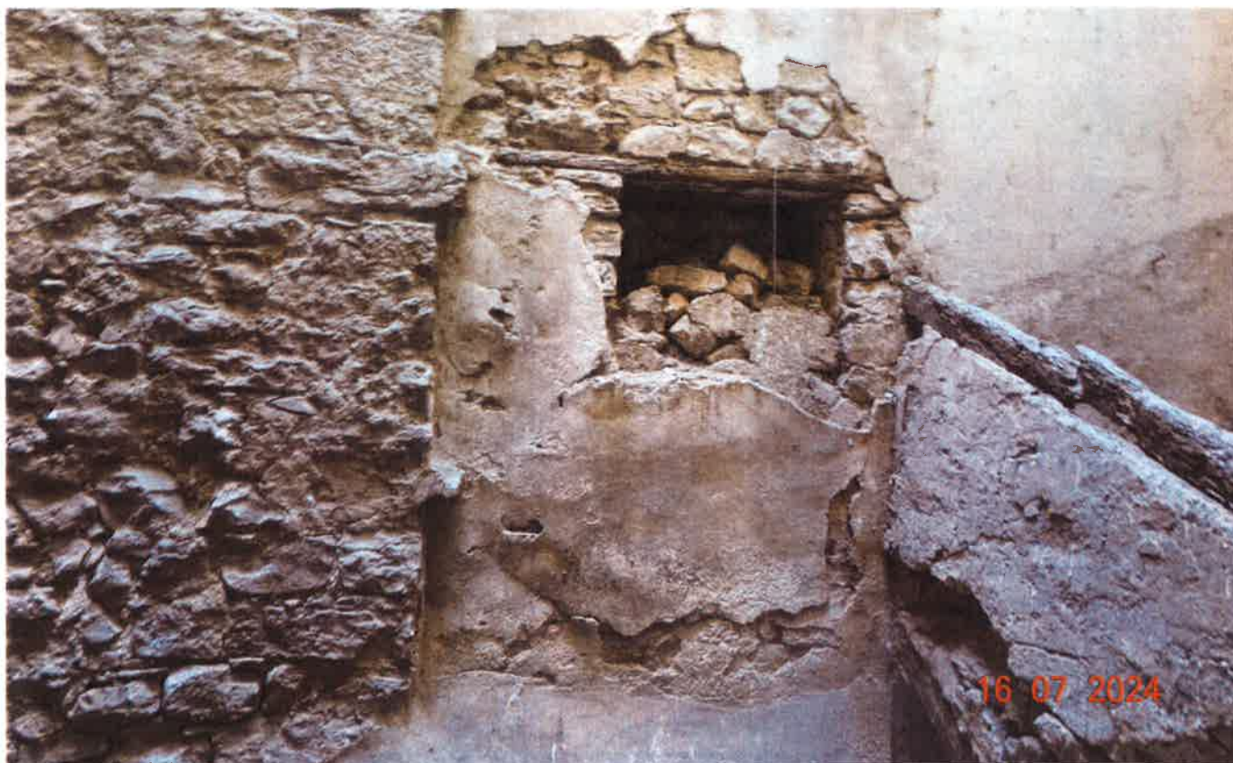
PURGE ET REBOUCHAGE TREMIES DANS MUR
