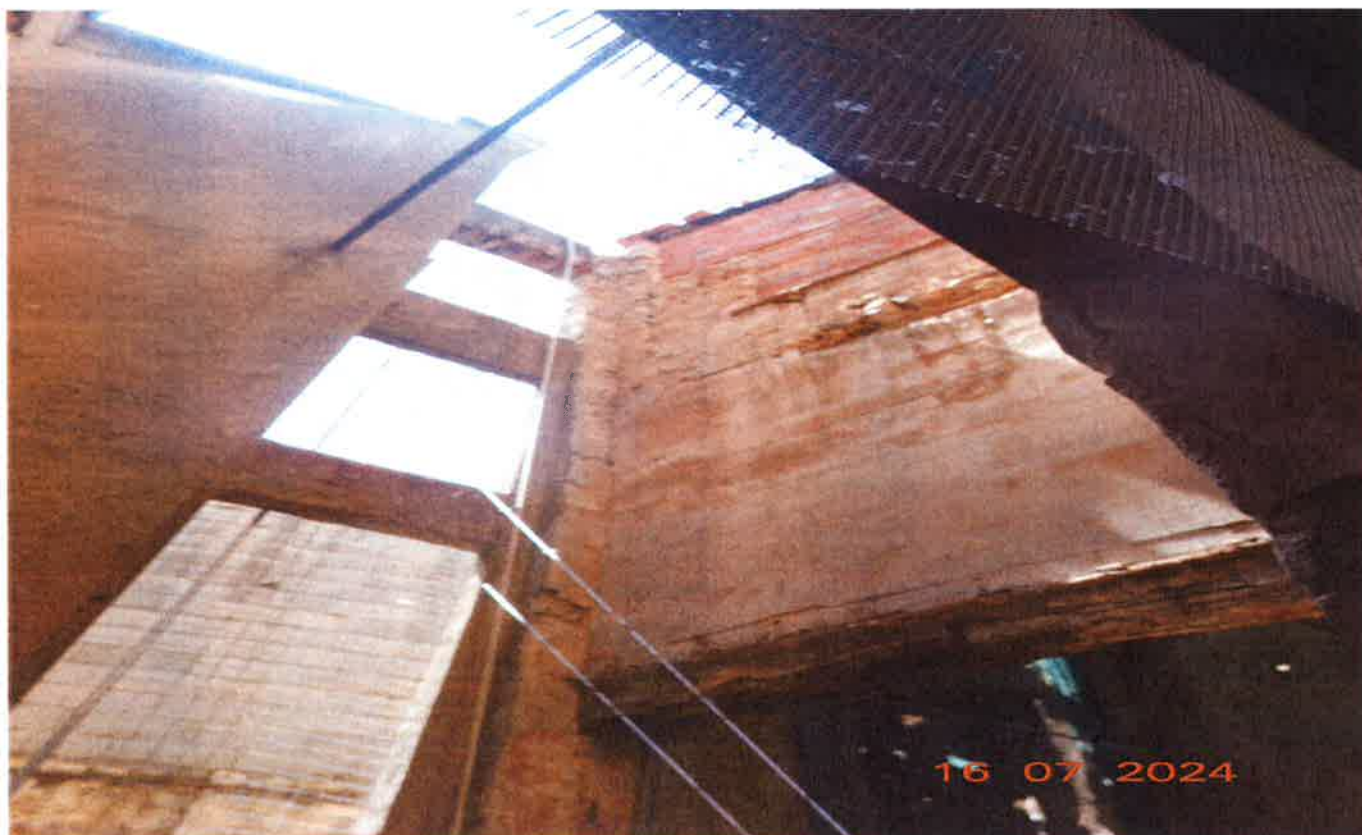
BUTONNAGE DE LA FACADE DANS LE PATIO
