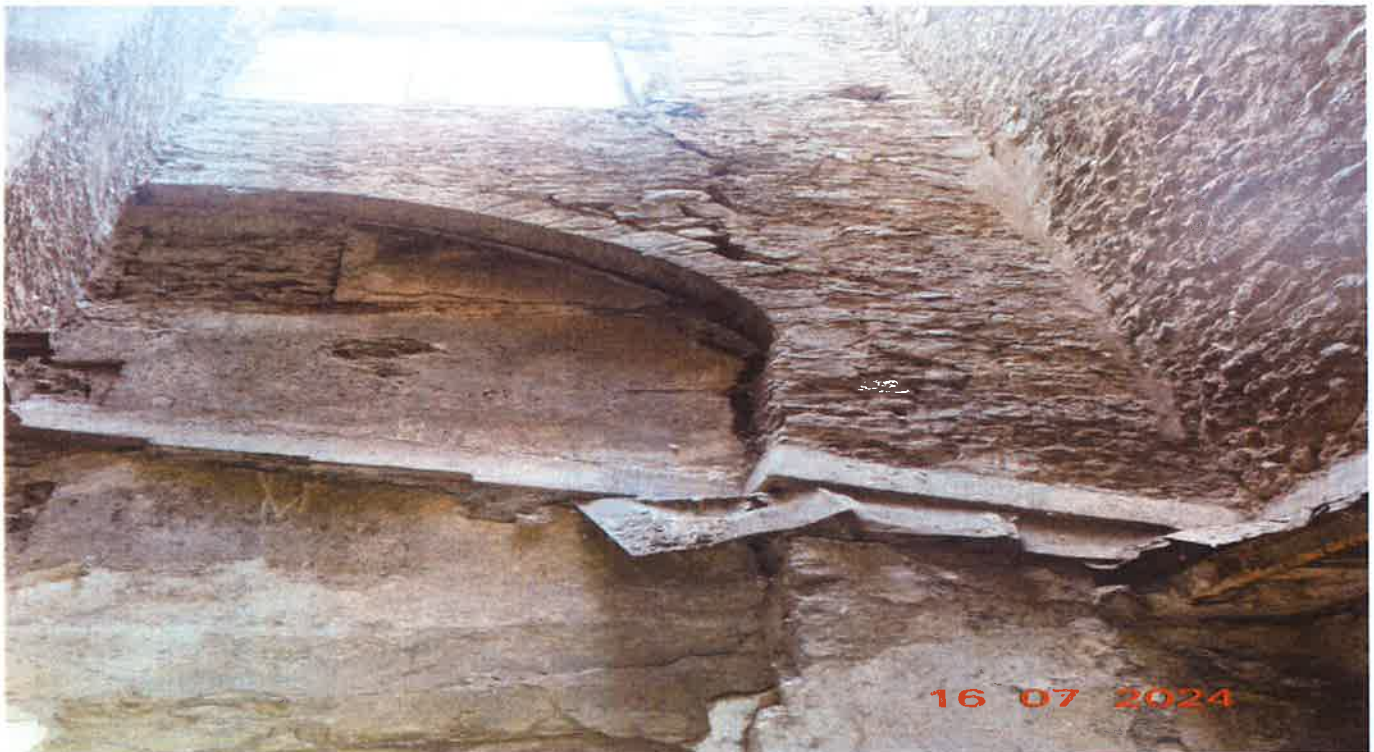
FISSURE ET LEZARDE FACADE DANS COUR INTERIEUR
